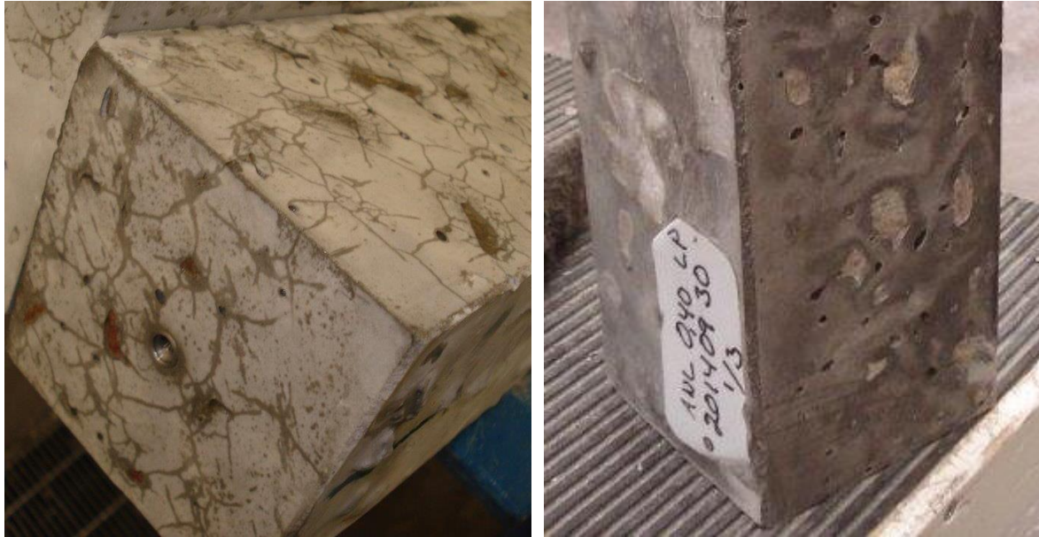
Figur 16. Till vänster foto visande mikrosprickor i balk med stenfyllnadsbetong, som vattenlagrats fram till krympmätning efter 231 dygn. Till höger foto som visar hur stenen exponeras i formytan av att bruket inte helt fyllt ut vid ytan.
